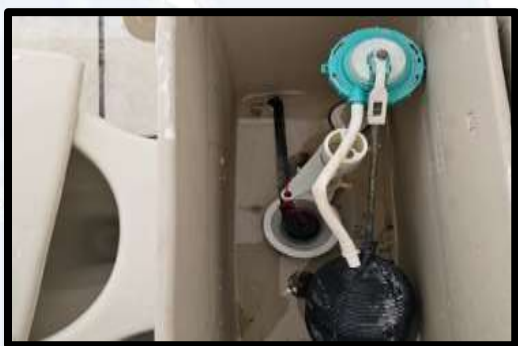
Imagen 38. Mantenimiento a baños.
