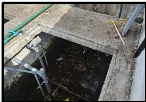
Imagen 36. Mantenimiento a planta tratadora.
