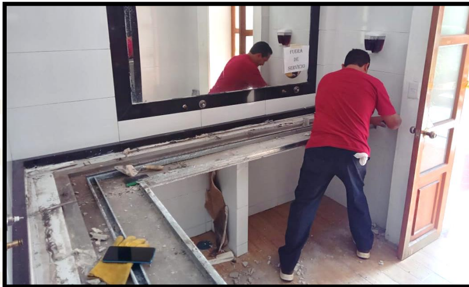
Figura 66. Mantenimiento a baños del Edificio B.
