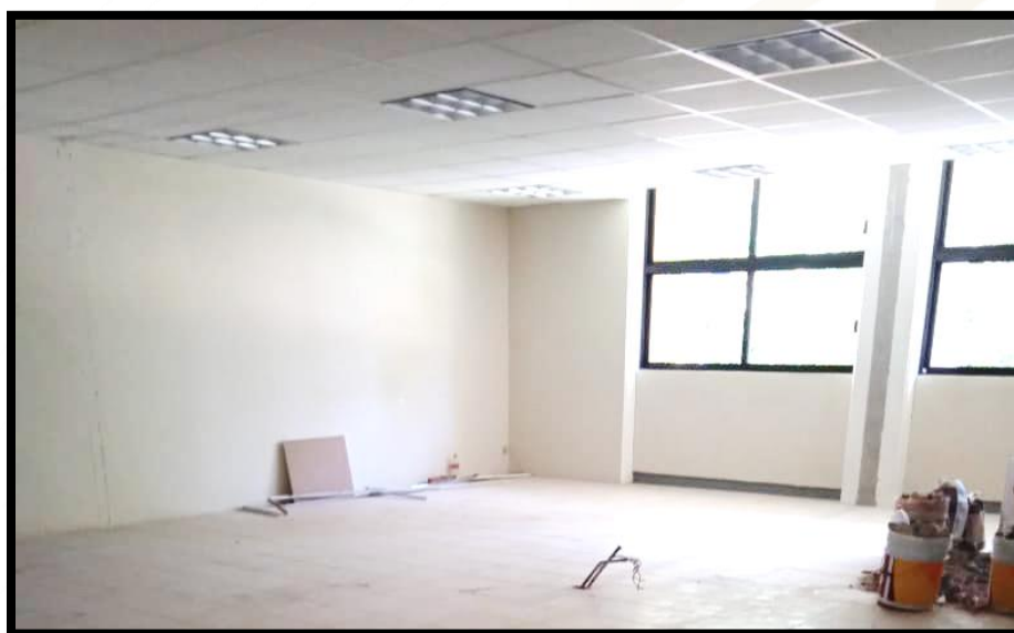
Figura 65. Mantenimiento a Edificio de Centro de Información.
