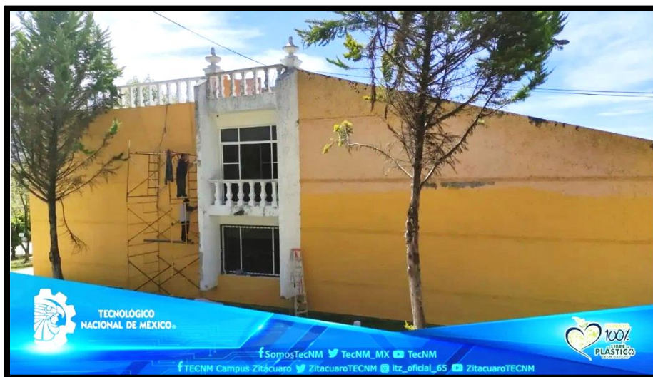
Figura 64. Mantenimiento a Edificio K.
