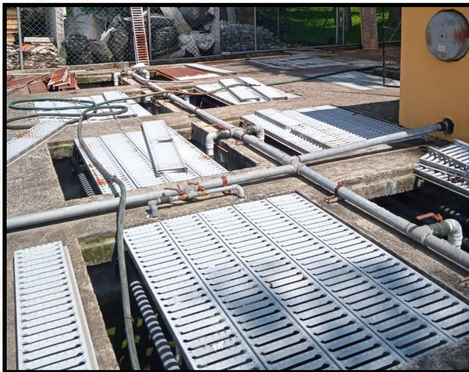
Figura 67. Mantenimiento a PTAR.
