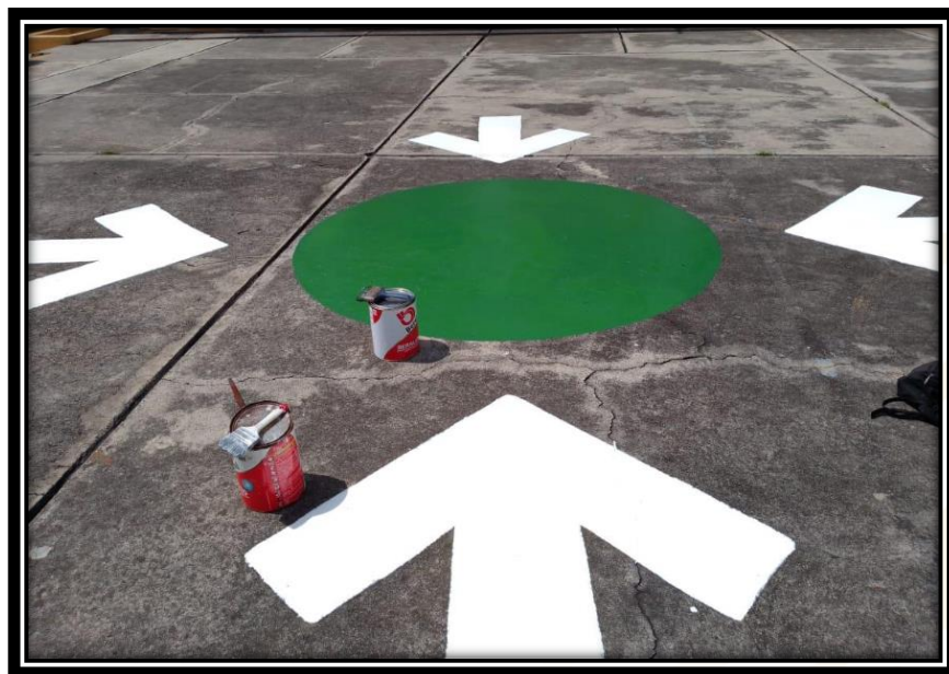
Figura 36 Pintura a punto de reunión Explanada Edificio A.
