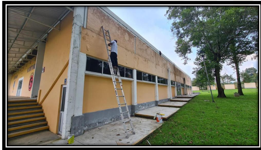
Figura 33. Pintura muro exterior Gimnasio Auditorio.
