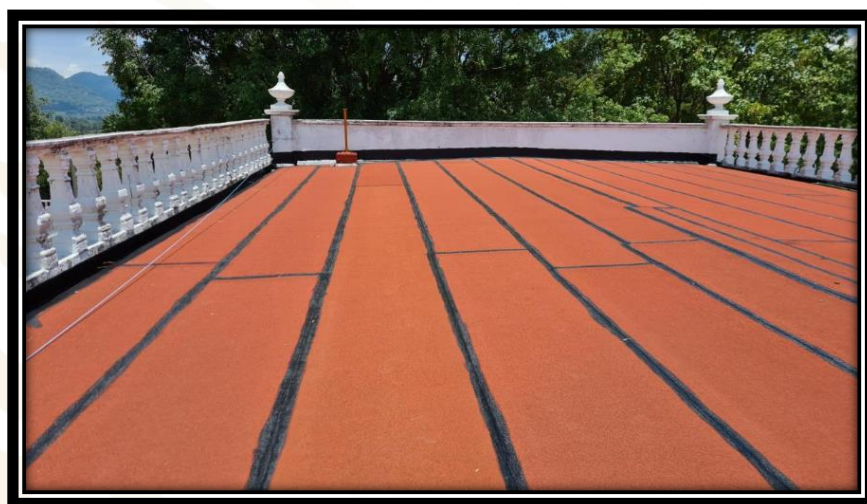
Figura 35. Impermeabilización Edificio B.
