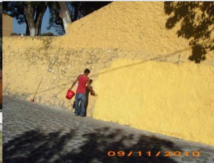
Pintura barda perimetral
